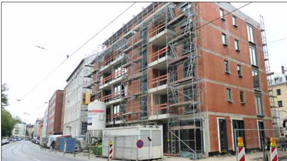
Die Baustelle Müllerstraße 14 Ende April
